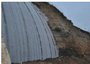
Fot.7. Fragment kopuły po wykonaniu naprawy warstwy izolacyjnej
