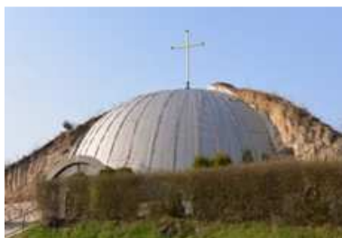
Fot.6. Kurhan po wykonaniu naprawy warstwy izolacyjnej
