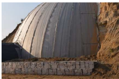
Fot.8. Zabezpieczanie kopuły koszami gabionowymi
